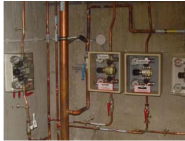
Canalisations, secondes détentes, alarmes, pots piège, filtres ...
